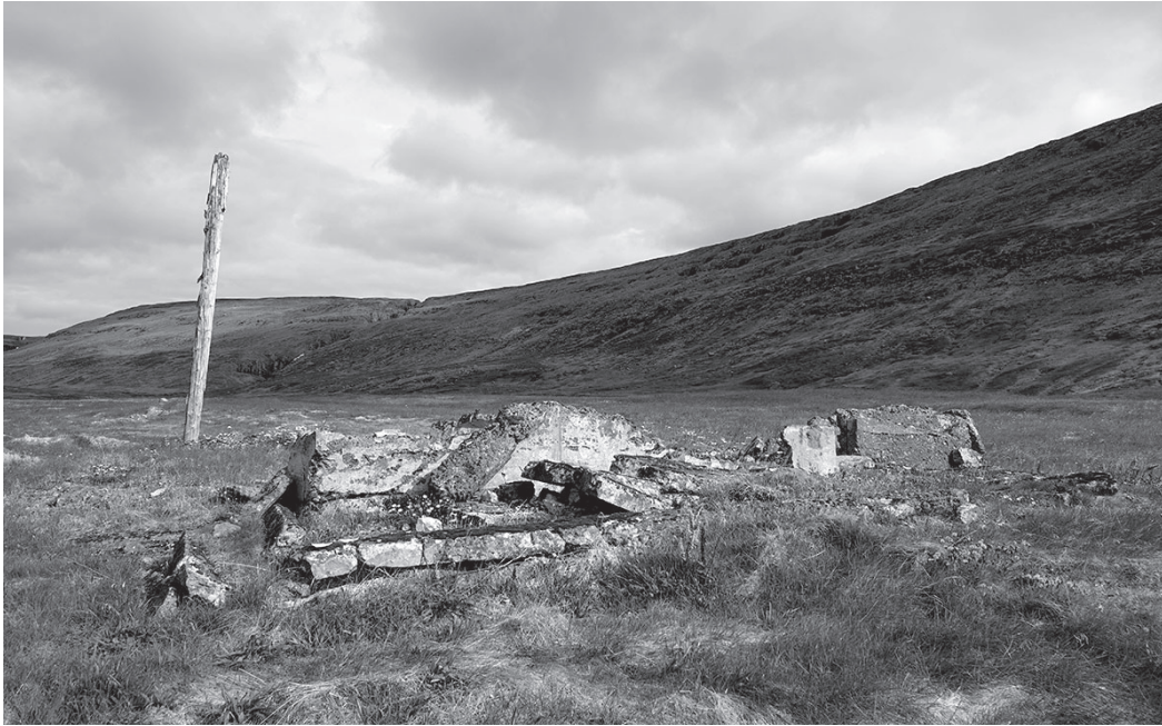
Abb. 1: Die Ruinen des Bauernhauses nahe dem Wasserfall Goðafoss, das auf einer Wiese der Elfen errichtet und von einer Schneelawine zerstört wurde.
